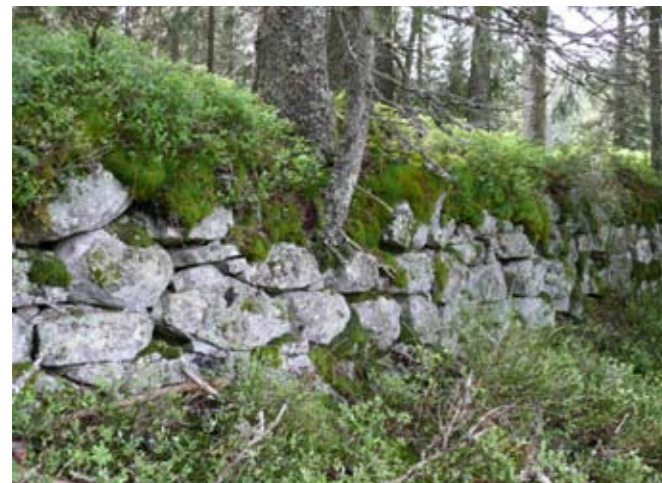
Staumauer im Gewann Unteres Moos
